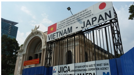
ホーチミンの地下鉄工事。日本が全面的に支援。
